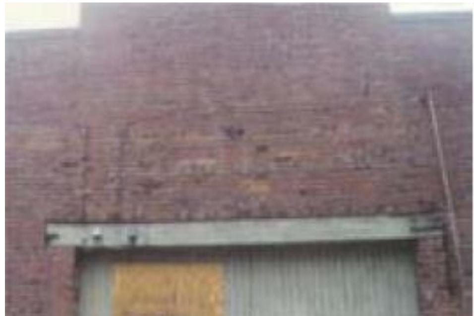
Izgled i generalna upotrebljivost konstrukcije mogu da budu dovedeni u pitanje ako je sračunati ugib greda, ploča ili konzola od kvazi-stalnih opterećenja veći od odnosa raspon/250.
